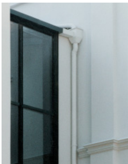
Regenpijp en dakgoot uit gekleurd roestvast staal als ontwerpelement
