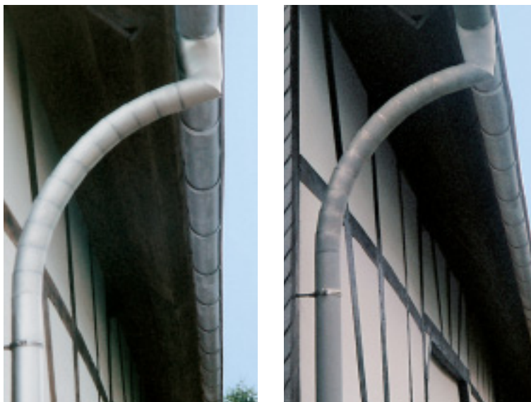
Versijnen van een patina op vertind roestvast staaltype 1.4404. Links de regenpijp bij plaatsing; rechts na twee jaar blootstelling aan de weersomstandigheden
