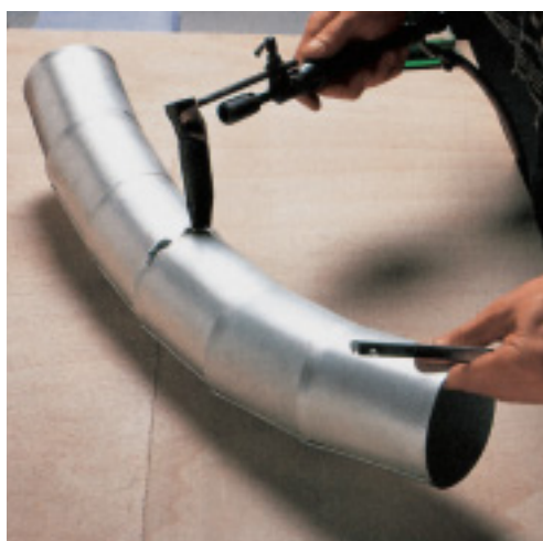
Soldering van een samengestelde bocht en van de hoekverbinding van een dakgoot
