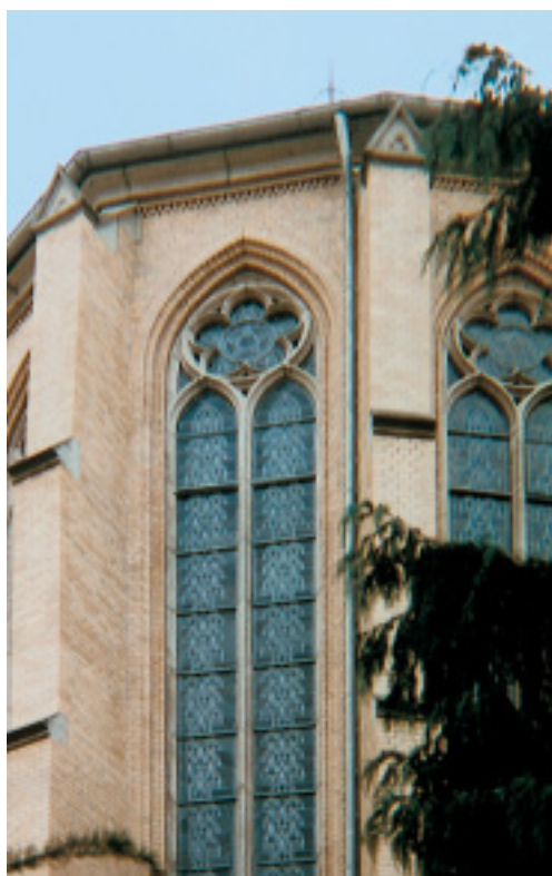
Gebruik van vertind ferritisch roestvast staaltype 1.4510 voor de stortpijpen van een geklasseerd kerkgebouw
